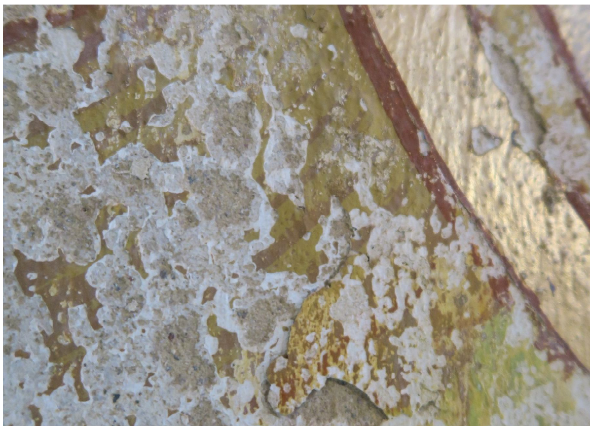
Makrosnímek poškozené barevné vrstvy malby
