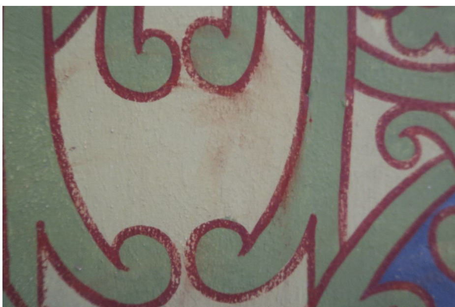
Makrosnímek malby v presbytáři, kdy je vidět zpráškovatělá barva kontur, ostatní barvy vykazují dobrou adhezi
