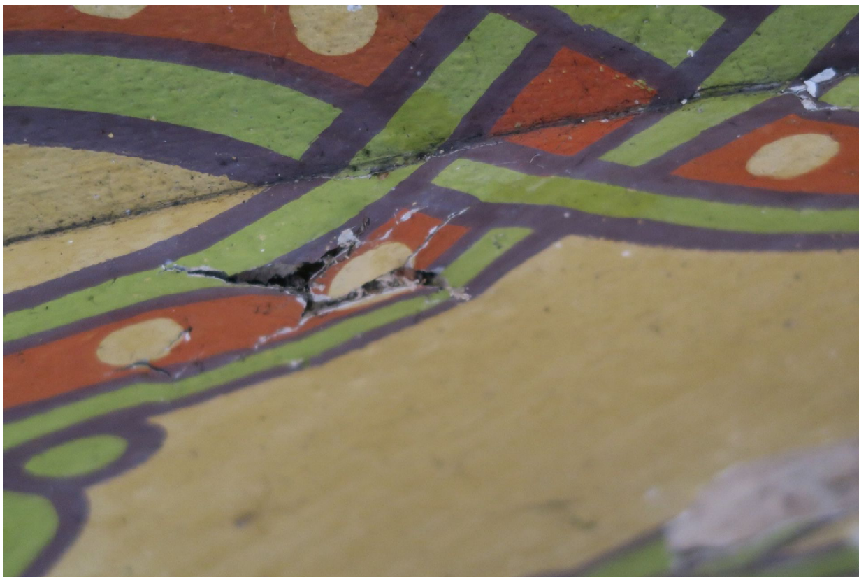
Detail uvolněných míst. Při vizuální prohlídce bez lešení zůstávají tyto místa neodhalená
