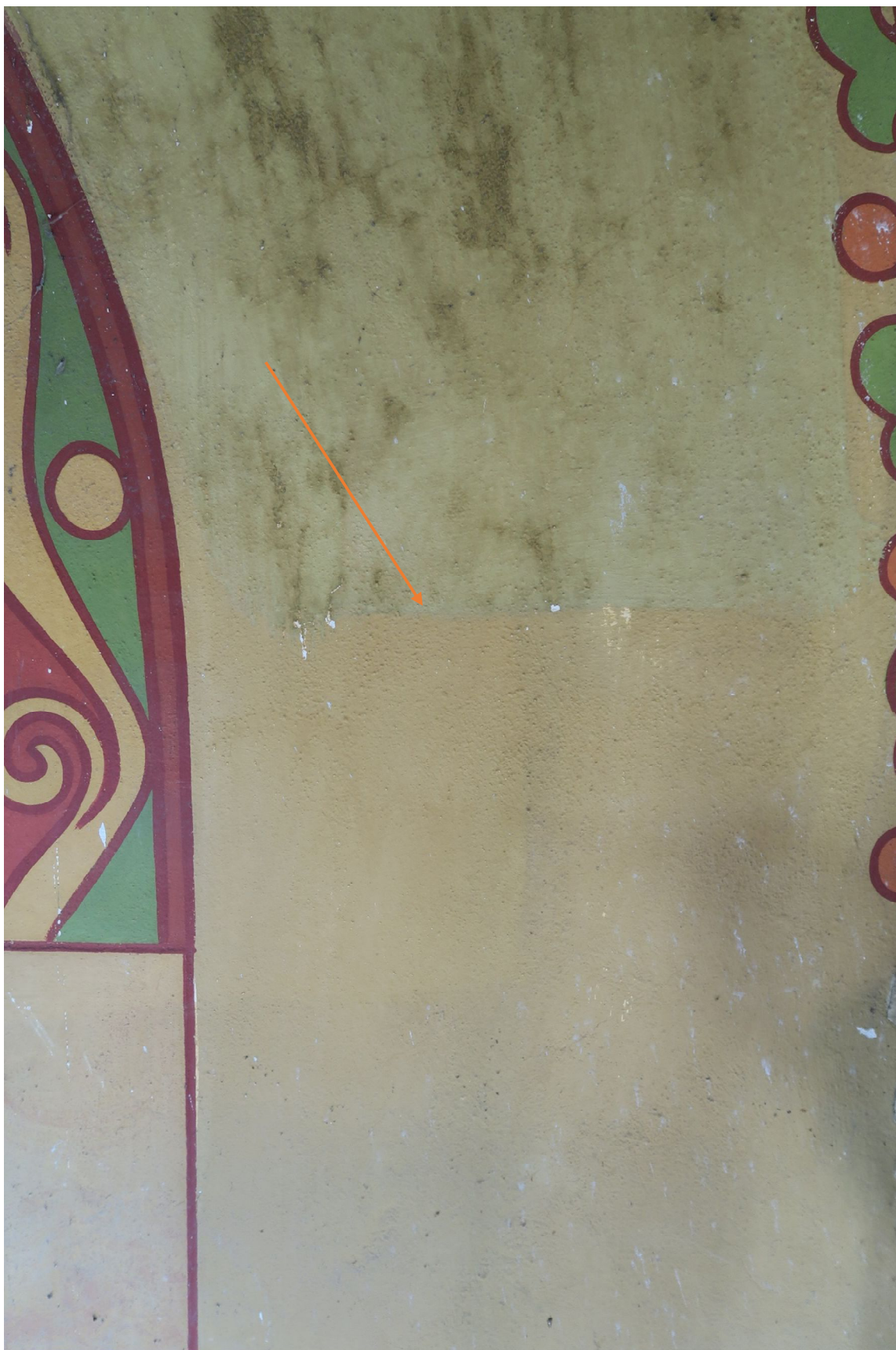
Šipka ukazuje druhotnou opravu na ploše stěny jižní lodě
