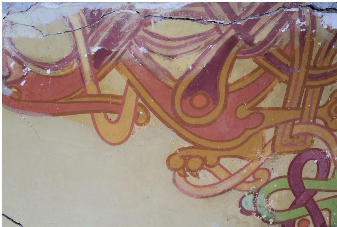
Detail oprav dekoru v místě trhliny. Tyto opravy je nutné odstranit, jelikož zcela neodpovídají svou barevností a provedením
