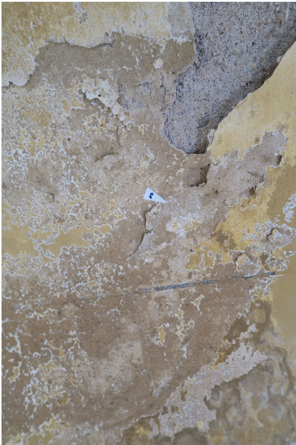
Snímek ukazuje výluhy do omítkové vrstvy na klenbě jižní lodě
