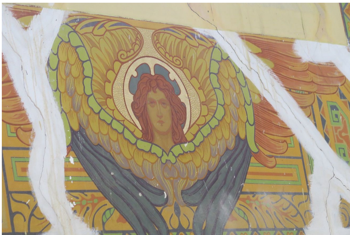
Pohled na malby na stěnách lodě kostela, kdy je vidět bílý disperzní nátěr, který měl zakrýt praskliny, ale ve větší části poškodil originální malbu
