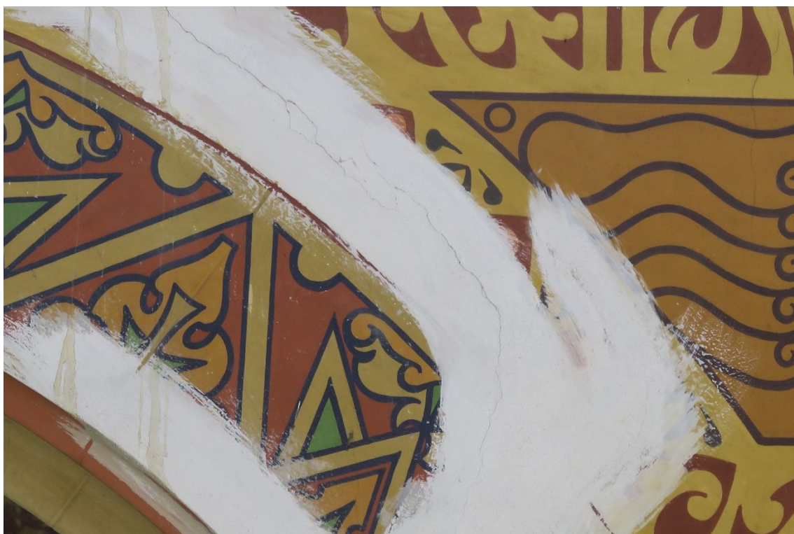
Tato oprava trhlin výrazně poškodila malby v lodi kostela
