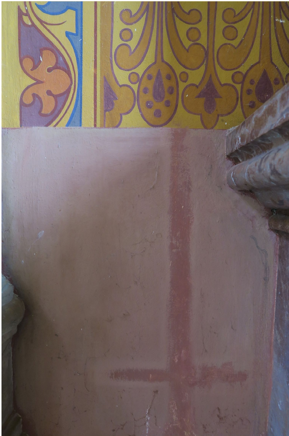
Snímek ukazuje páskovou sondu v dolní monochromní ploše v severní lodi u bočního oltáře, která svou barevností neodpovídá původnímu barevnému řešení
