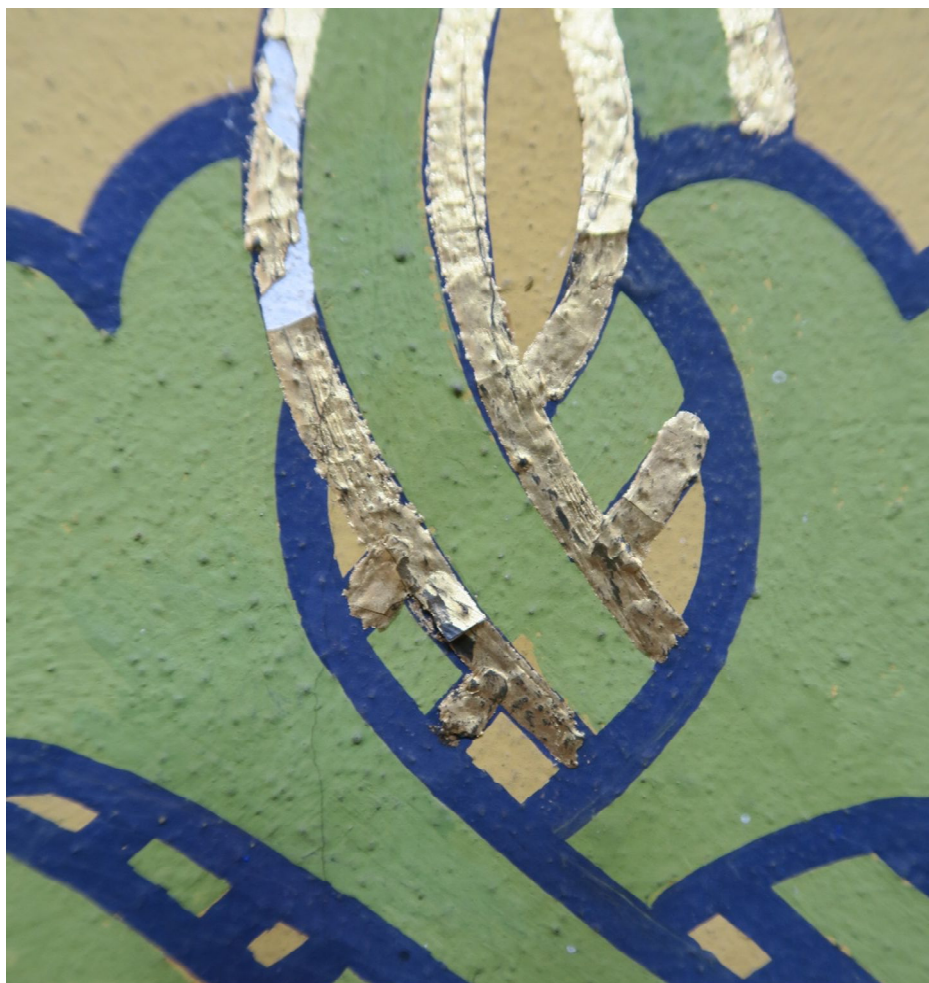
Poškození zlacených linek, kdy dochází k oddělení podkladní vrstvy od bílého nátěru
