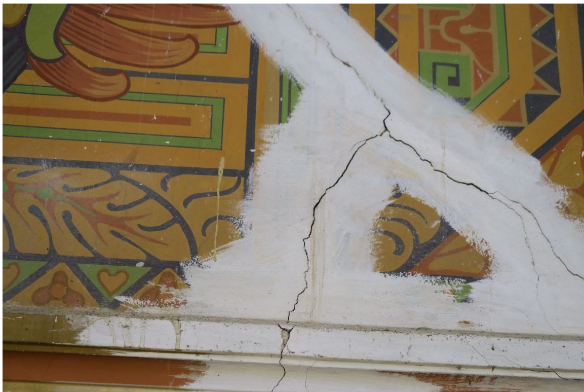
Trhliny v místě oprav. Po odstranění bílého nátěru výrazným způsobem dojde ke snížení rozsahu poškození originálu
