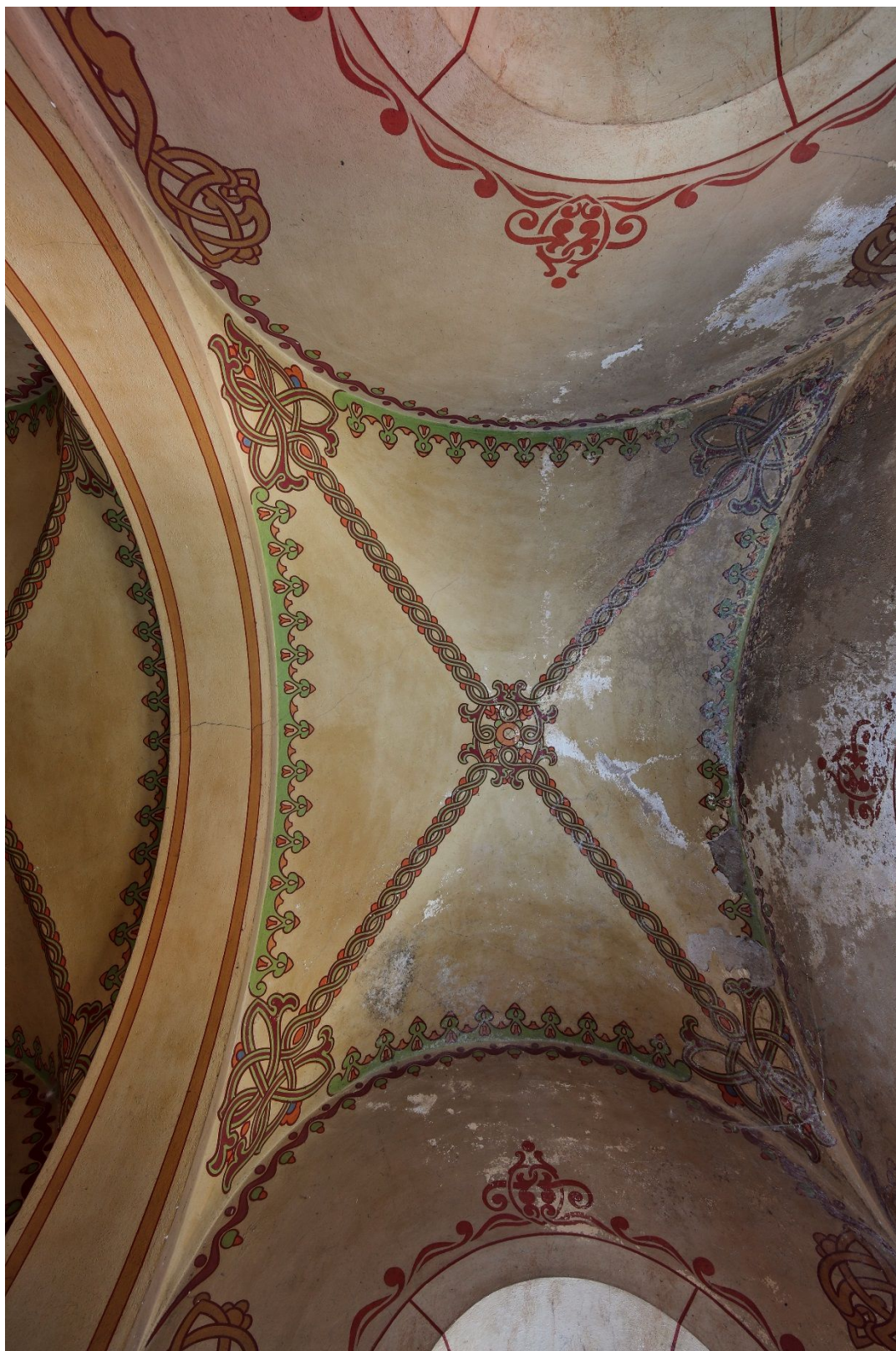
Snímek ukazuje výrazné poškození maleb na klenbě křestní kaple, na snímku jsou zřetelně vidět odpadlá místa barevné vrstvy a změna barevnosti v místě dlouhodobého zatékání dešťové vody
