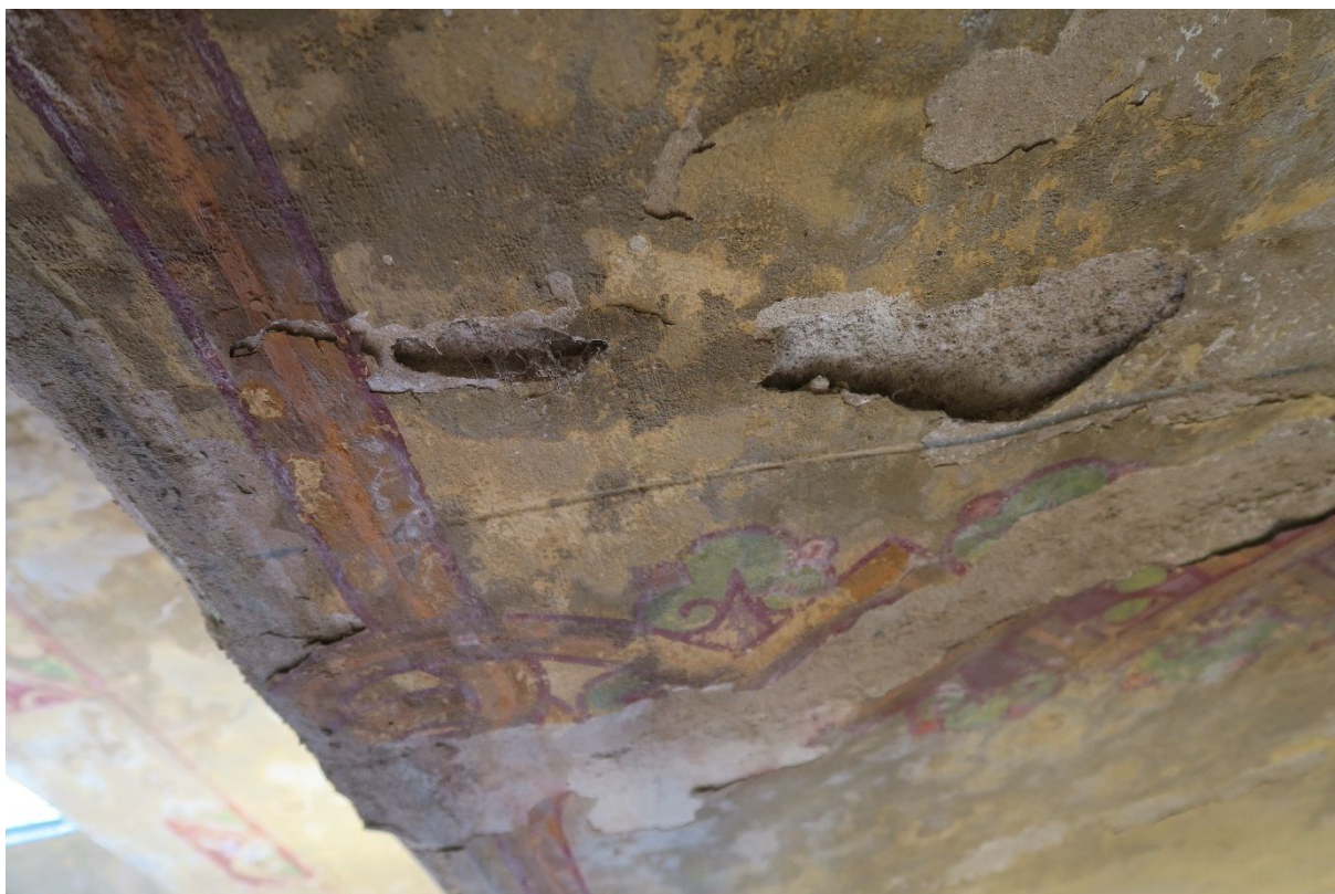
Detail havarijního stavu malby na klenbě jižní lodě
