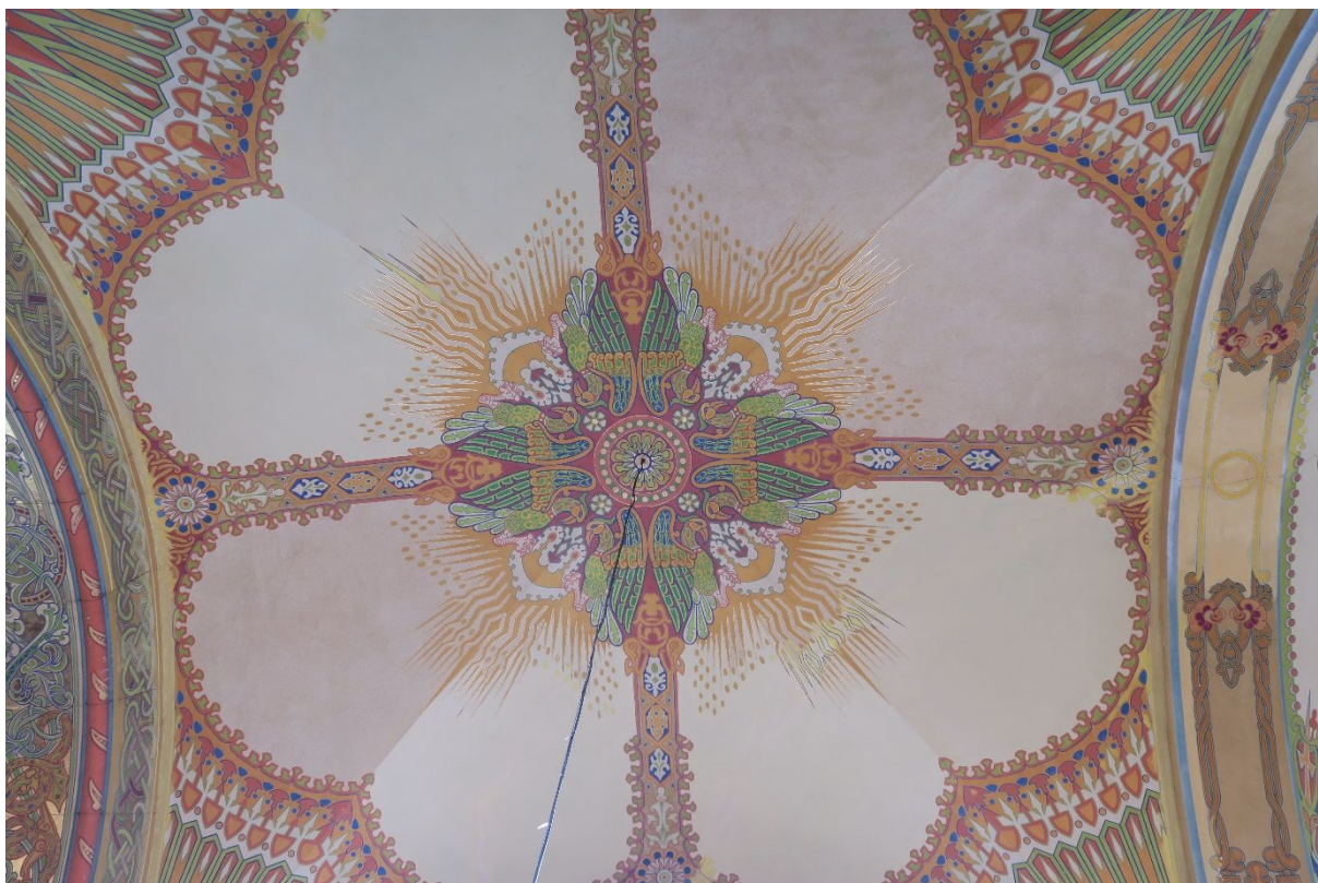
Pohled do klenby lodě kostela. Zde jsou vidět poškozené části malby zatékáním, kdy došlo k probarvení malby.
