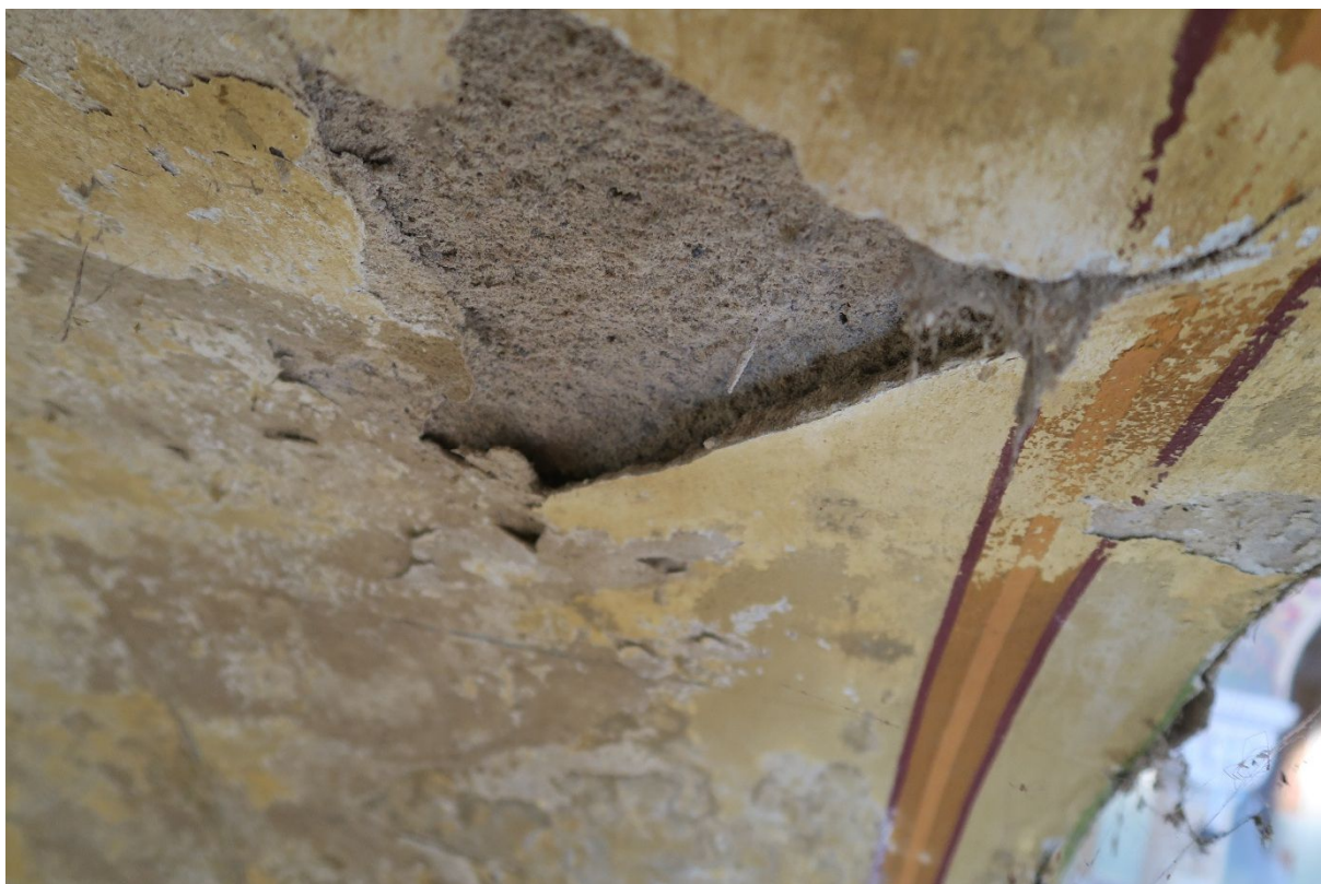
Snímek ukazuje uvolněnou část omítkové vrstvy v místě klenby jižní lodě. Zde došlo k vysokému snížení soudržnosti podkladní omítkové vrstvy.
