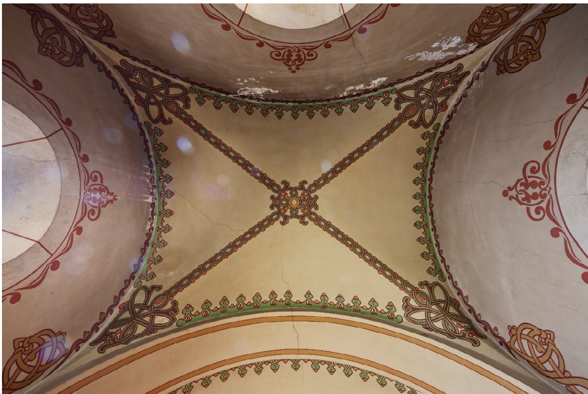
Pohled do klenby křestní kaple. Na klenbě i stěnách je viditelná síť prasklin a trhlin.
