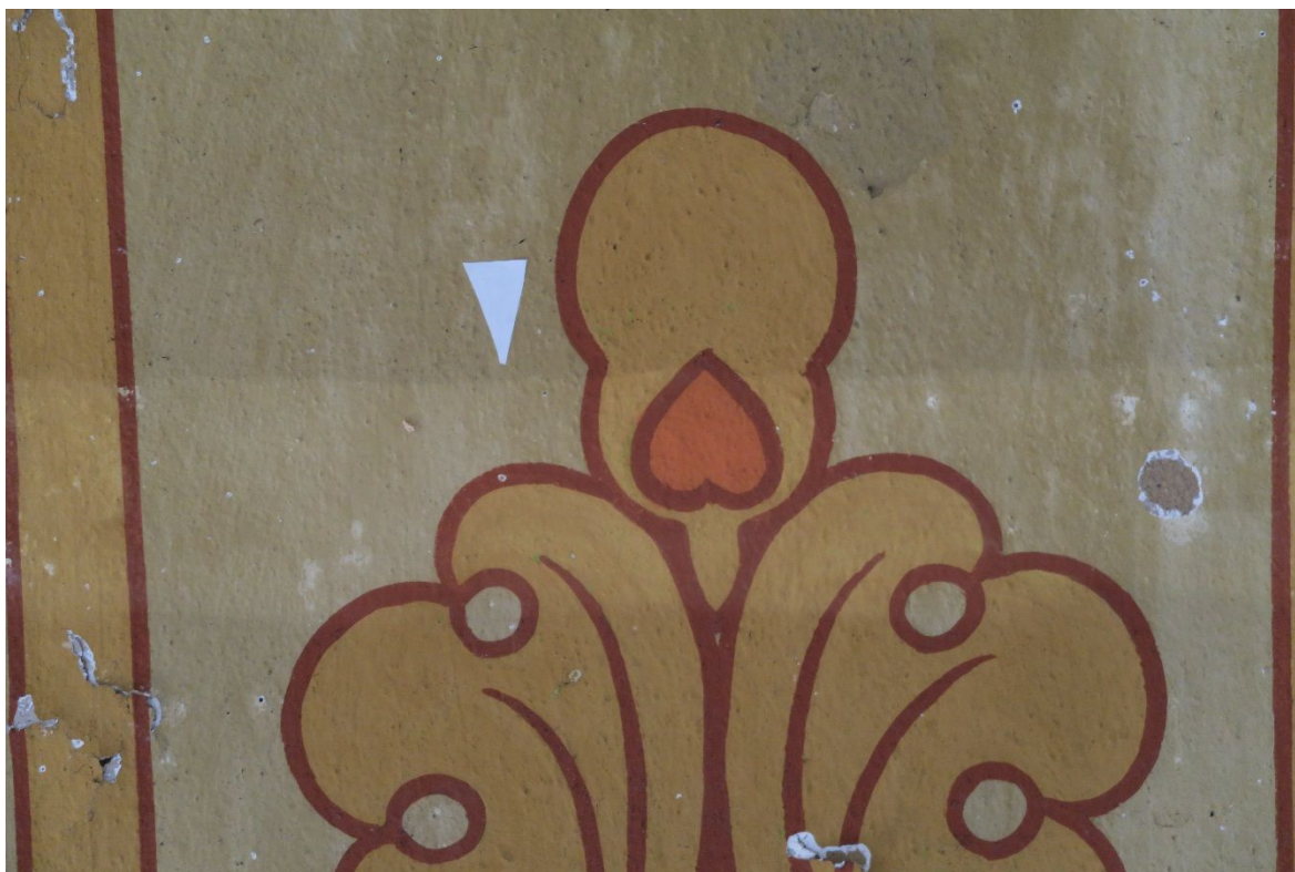
Detail provedené sondy na pasu klenby severní lodě ukazuje výraznou změnu barevnosti po sejmutí mastných a prachových depozitů
