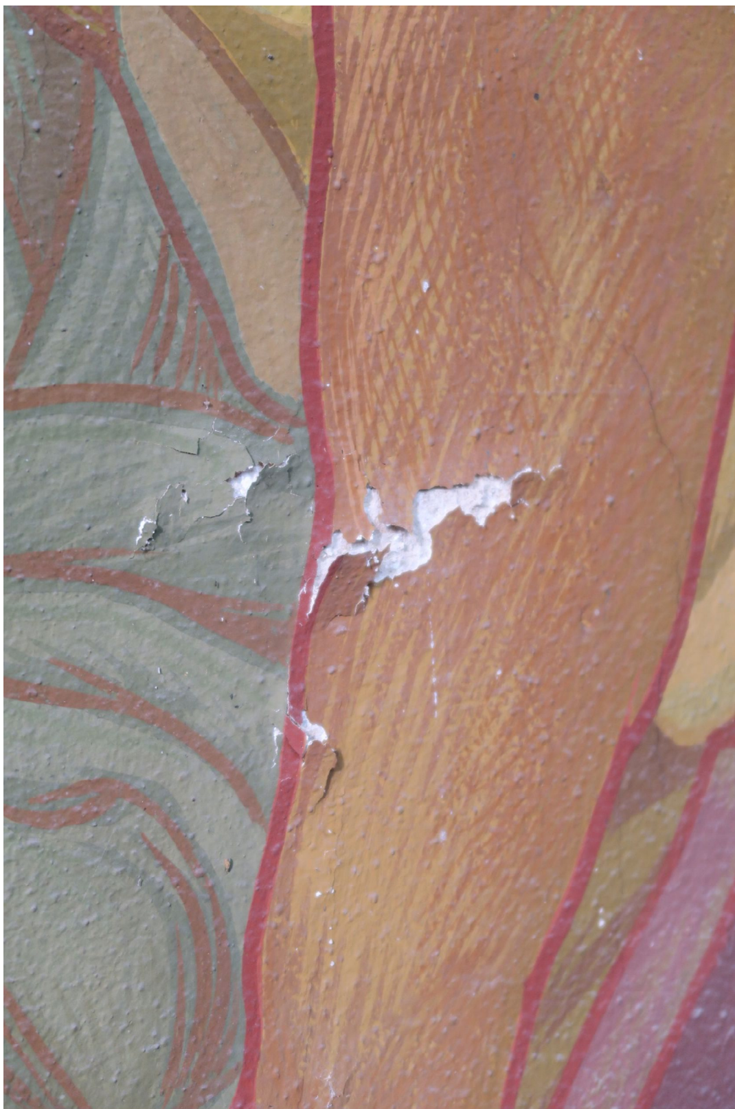
Makrosnímek figurální malby na stěně presbytáře ukazuje drobná uvolnění malby od podkladního bílého nátěru. Zde dochází k odpadávání šupinek malby, a tak nevratné ztrátě originálu
