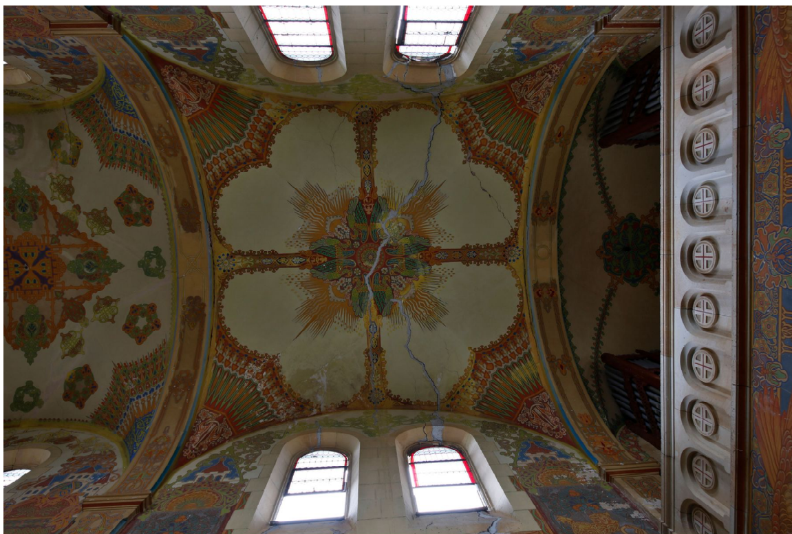
Pohled na klenbu hlavní loď, která je poškozena prasklinami a zatékáním
