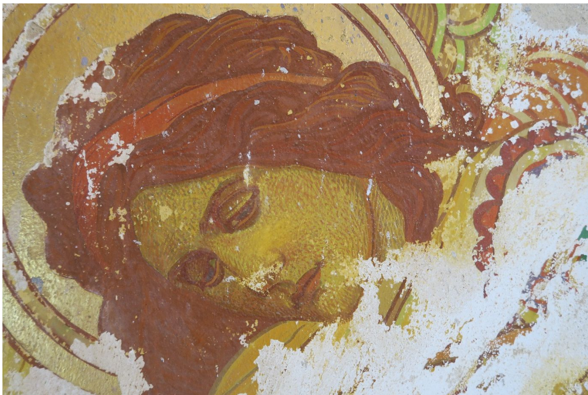
Snímek ukazuje poškození malby dlouhodobým zatékáním
