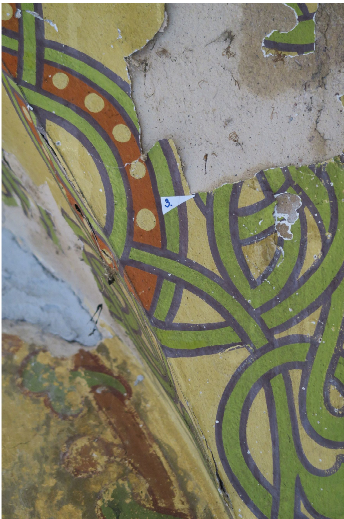
V průběhu zatékání došlo k vytvoření dutých kaveren, kde došlo k odpadnutí části maleb, na dalších místech toto dnes hrozí.
