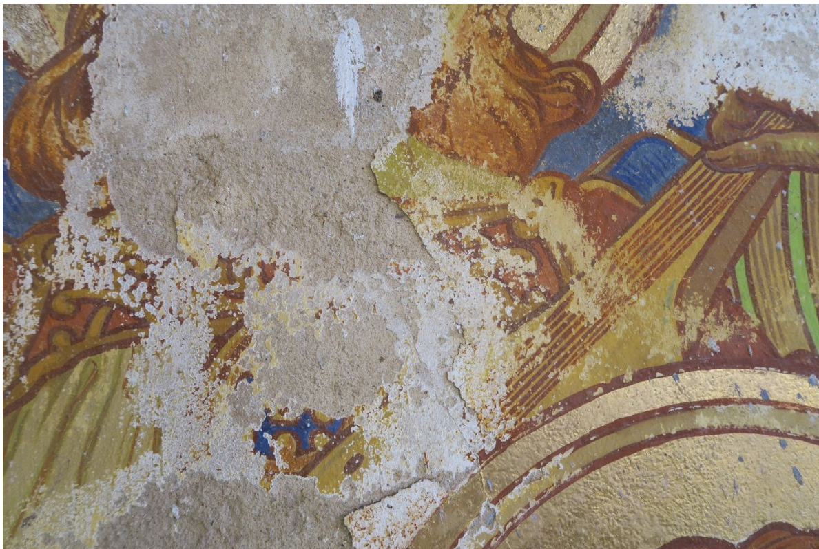
Detail odpadlé malby a rozrušené omítkové vrstvy u výjevů hrajících andělů
