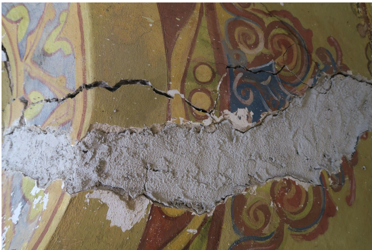
Oprava odpadlých míst. Na fotografii je vidět nekvalitně domalovaný ornament v místě poškození
