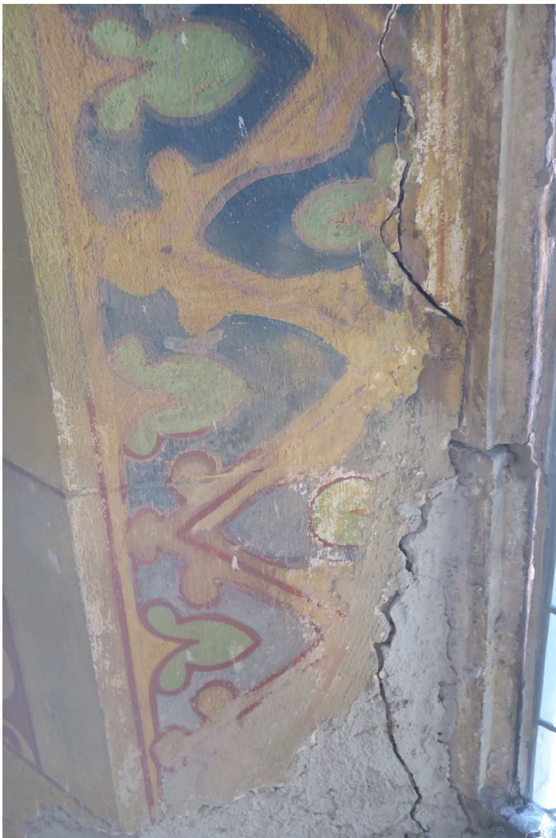
Na fotografii špalety okna v jižní lodi je vidět zcela nevyhovující rekonstrukci dekoru v místě poškození a uvolněnou nově provedenou plombu v místě trhliny. Nová omítka má vysoký obsah cementu.
