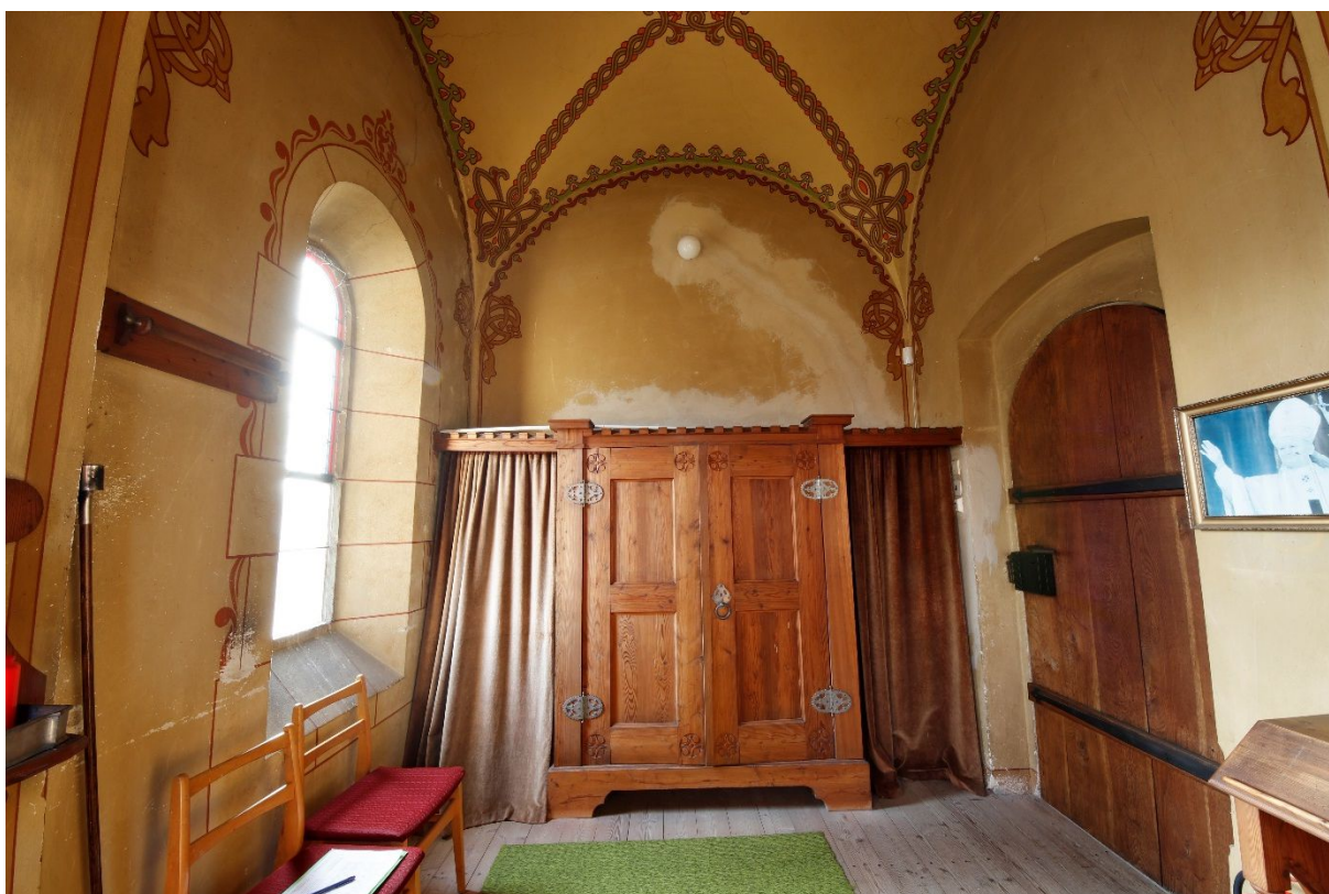
Celkový pohled do sakristie – zde jsou malby pokryty vrstvou prachových nečistot a mechanicky poškozeny. Dolní snímek ukazuje poškození monochromní výmalby novou elektroinstalací
